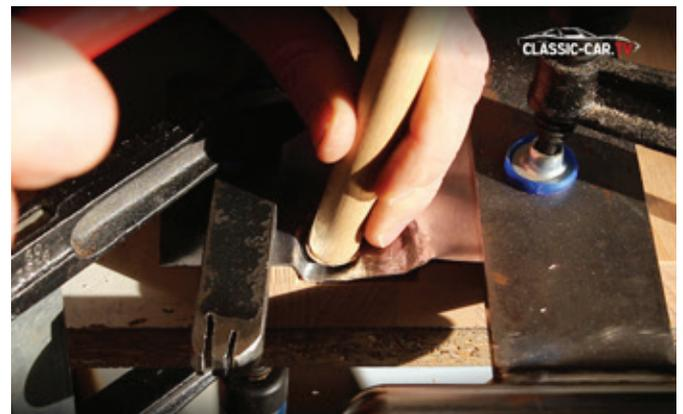
An den A- oder B-Säulen finden sich bei älteren Fahrzeugen immer wieder Fangschlösser. Für Ersatzbleche müssen diese nachgeformt werden. Dazu wird in einen Hartholzblock mit einer Oberfräse die Form und Tiefe der Sicke ein gefräst. Diese Schablone dient später für das Treiben der Fangschloss-Sicke.
