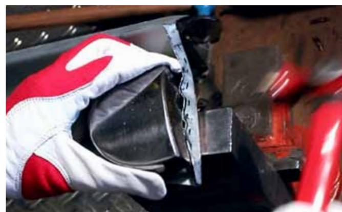
Nun geht es an die Abschluss-Kante am Radlauf. Der Kotflügel hat entlang des Radlaufs eine erhabene Sicke. Die gilt es zuerst nachzufertigen.
