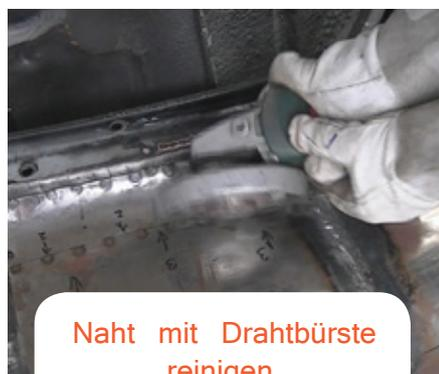
Naht mit Drahtbürste reinigen.
